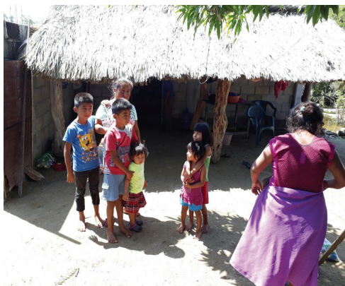
Figura 4. Vivienda con materiales de construcción combinados morillos, palma y materiales de concreto. Foto. Autor. Octubre de 2017.
